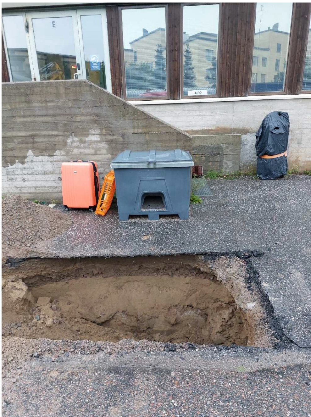
Kuva 6. Koekuopassa SE3 tuli esiin rakennuksen puolella portaikon betonirakenteita.
