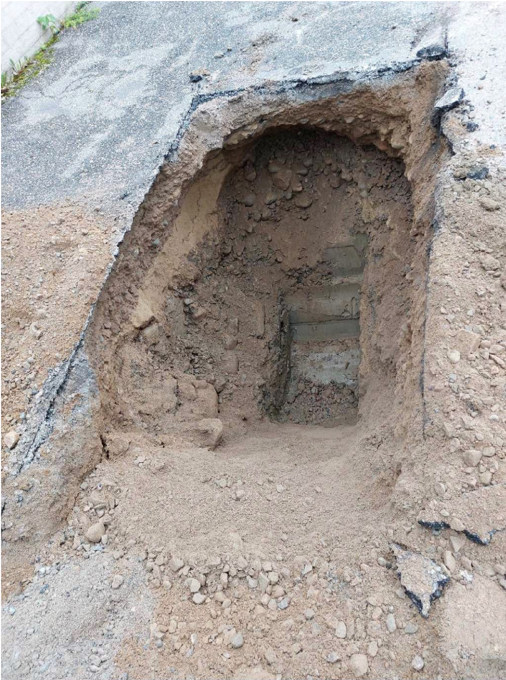
Kuva 4. Koekuopassa SE2 savikerros alkoi 1-1,6 m välillä. Koekuoppa sijoittui oletetun öljysäiliön ja sen suoja-alataan kohdalle. Merkkejä säiliöstä tai sen rakenteista ei todettu.
