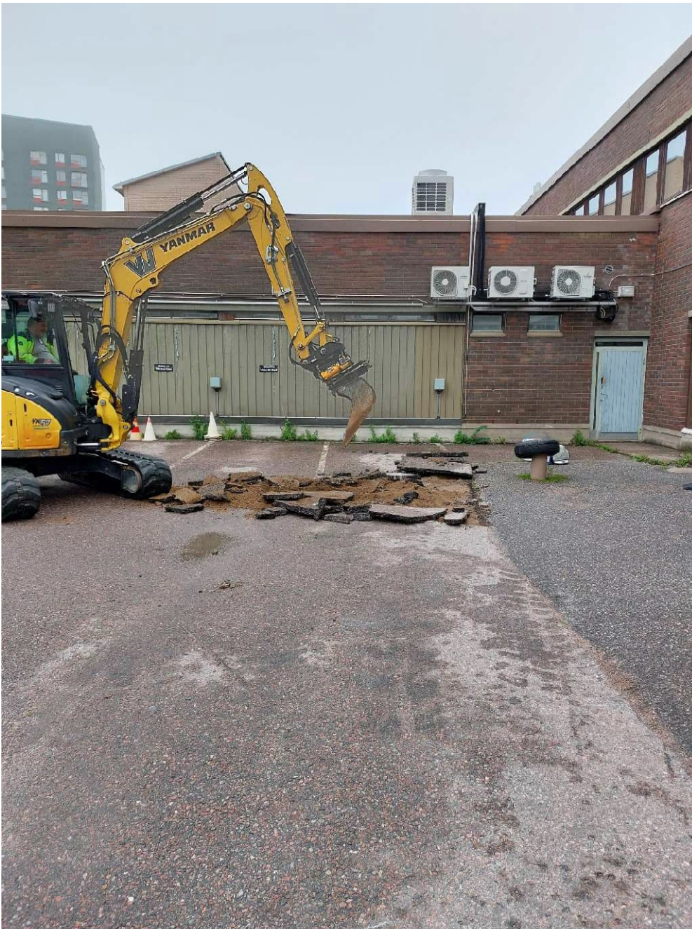
Kuva 2. Koekuoppa SE1 kaivettiin välittömsäti oletetun öljysäiliön viereen.
