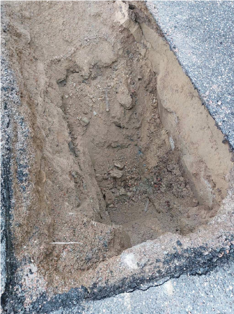
Kuva 6. Koekuopan SE3 betonirakenne havaittavissa kuvan oikeassa laidassa seinämässä. Koekuoppa sijoittui oletetun öljysäiliön ja sen suoja-alataan kohdalle. Merkkejä säiliöstä tai sen rakenteista ei todettu.
