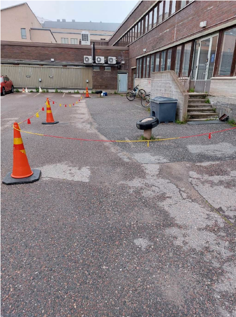
Kuva 1. Yeiskuva tutkimusalueesta. Aluetta rajattu lippusiimalla.
