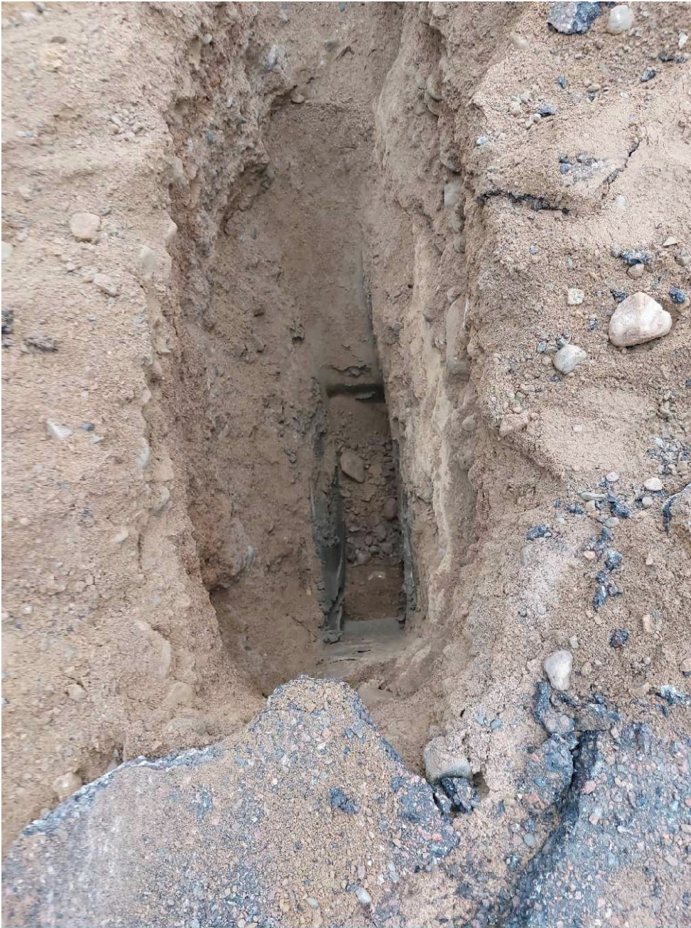
Kuva 3. Koekuopassa SE1 asfalttikerroksen alla oli siisti täyttömaa ja luonnon savi, eikä havaintoja öljysäiliöstä tai siihen liittyneistä rakenteista havaittu.
